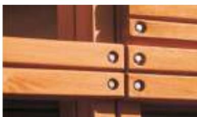
Wszystkie drewniane elementy są poddawane czterostronnej obróbce i mają zaokrąglone krawędzie. Śruby i nakrętki są wpuszczone w głąb deski.
