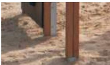
Fundamenty metalowe zapewniają izolację drewnianej konstrukcji od podłoża gwarantując jej trwałość.
